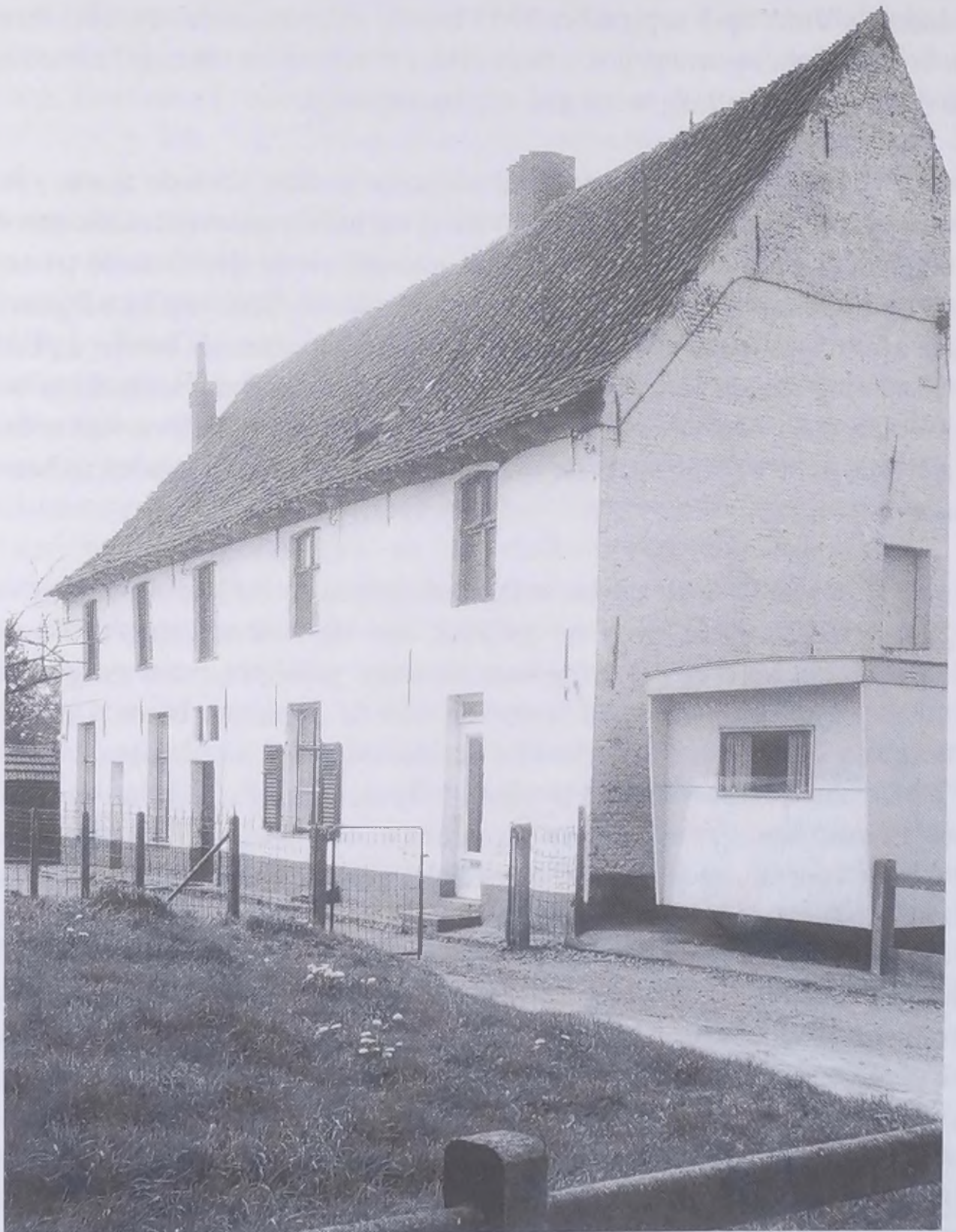
De oostgevel van de eerste pastorie van Landegem in 1989. Het gebouw werd in 1999 afgebroken. (Foto AROHM, Monumenten en Landschappen)
