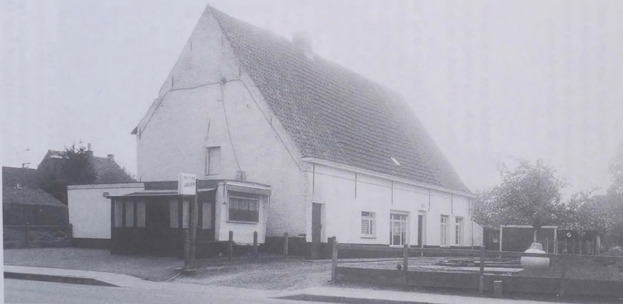
De westgevel van de eerste pastorie van Landegem in 1989. (Foto AROHM, Monumenten en Landschappen)
